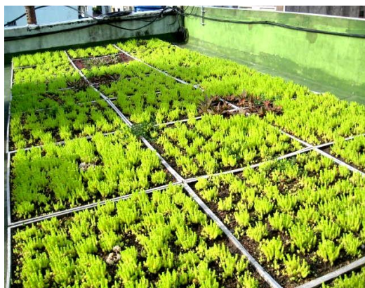
Figura 12. Cubierta extensiva en módulos ya colocados
