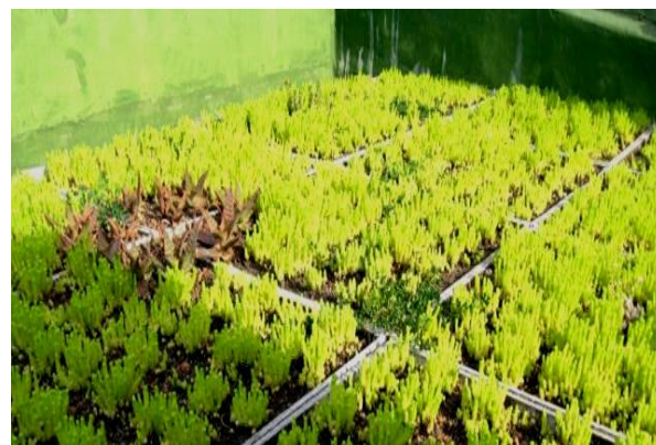
Figura 12. Cubierta extensiva en módulos ya colocados
